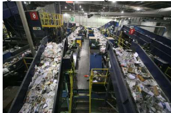
Figura 2 – Usina de Reciclagem
