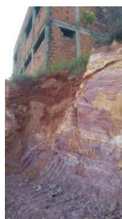
Figura 1- Corte na Av Castelo Branco-João Monlevade (MG)
